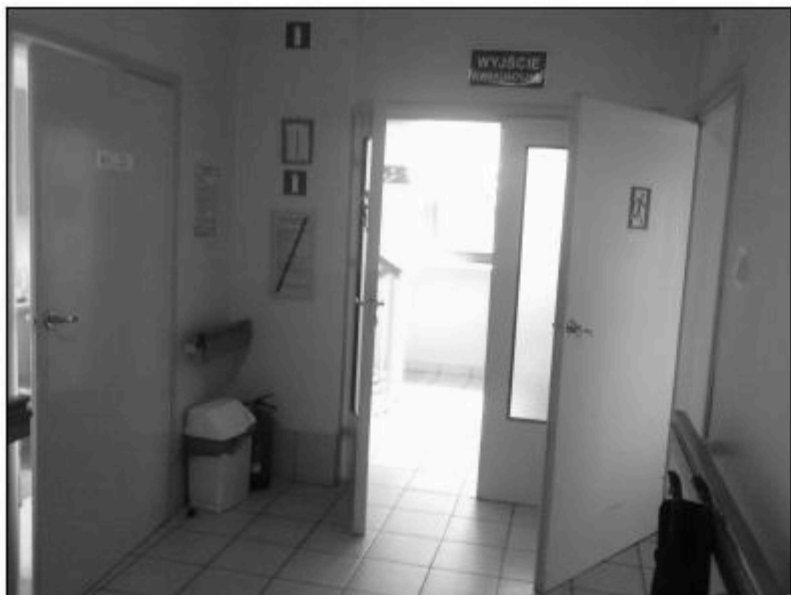
I piétro - klatka schodowa strefa "B"
