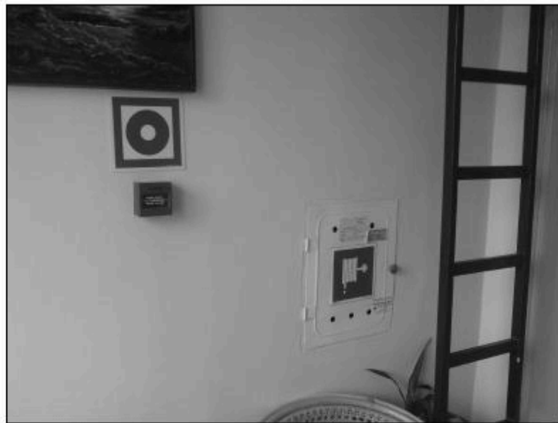
II piêtro - klatka schodowa strefa "B"
