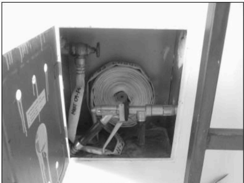
II piêtro - klatka schodowa strefa "B"
